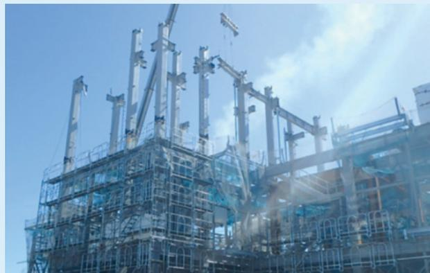
2019年7月の完成を目指し、ライフサイエンス事業部の戦略品であるリンゴ酸の製造設備の建設工事が順調に進んでいます。建設場所は、三井化学株式会社から有機酸設備(無水マレイン酸・フマル酸の製造)を譲り受け、昨年11月にスタートした鹿島事業所となります。完成すれば、最新鋭の設備で、原料である無水マレイン酸からリンゴ酸の一貫生産が実現します。大阪工場に続く2つ目のリンゴ酸設備による生産増強により、さらなるリンゴ酸ビジネスの拡大に挑戦していきます。
