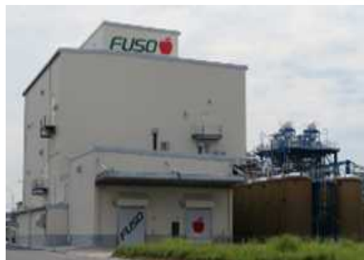
【新リンゴ酸製造棟】
